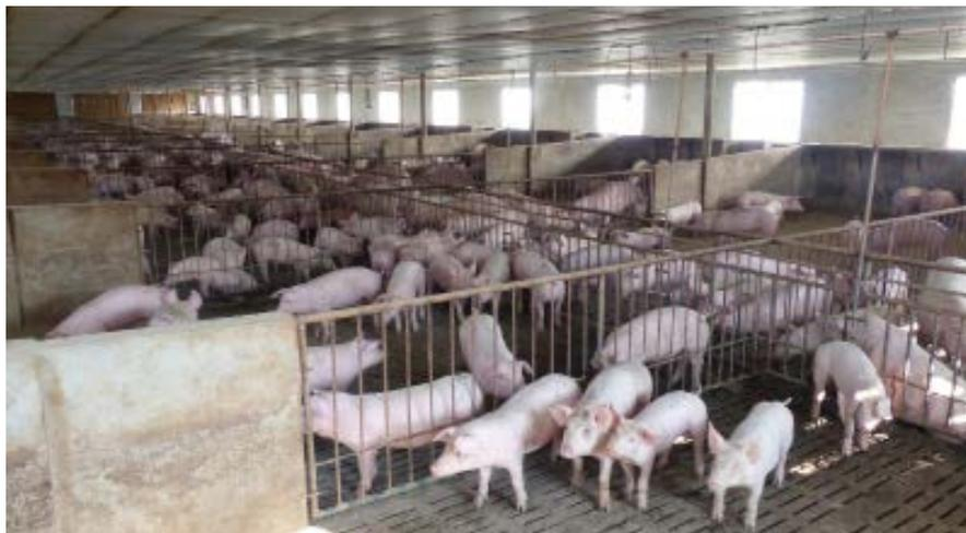
**Großraum-Maststall mit Betonspalten, isolierter Decke, Trockenfutterautomaten und Tunnellüftung nach amerikanischem Vorbild.**
