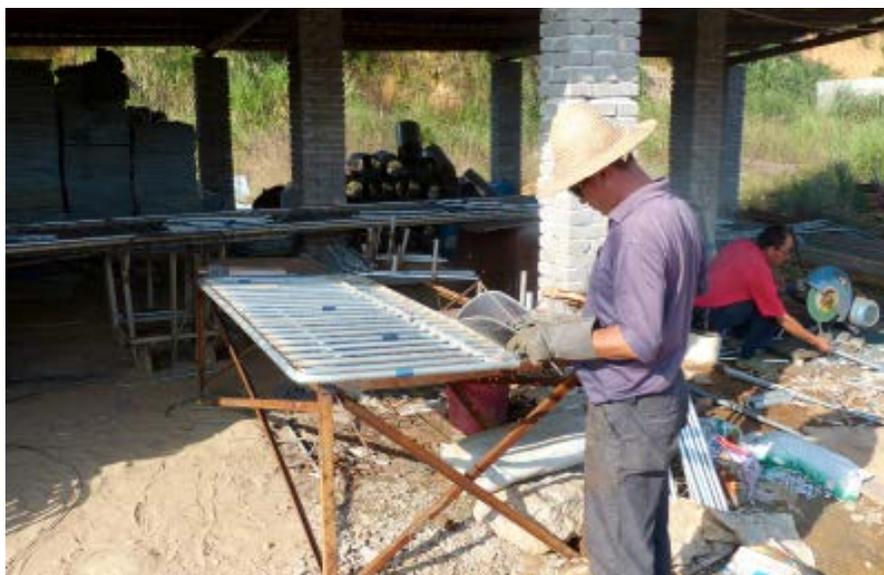
**Stallbau in der Provinz Jiangxi. Hier schweißen Mitarbeiter der Farm die Buchtenabtrennungen aus verzinkten Rohren selbst.**
